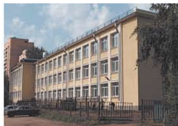
Школа-интернат № 9 (ул. Старцева, 7, лит. А) Ведется комплексный капитальный ремонт здания специальной (коррекционной) общеобразовательной школы-интерната № 9 Калининского района. Открытие обновленной школы состоится 1 сентября этого года.
