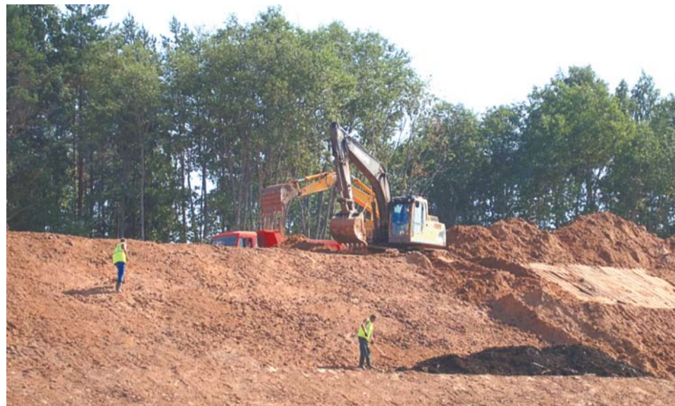
ВОДРАЗДЕЛЬНЫЙ КАНАЛ ВОЛГО-БАЛТИЙСКОГО ВОДНОГО ПУТИ. ЗЕМЛЯНЫЕ РАБОТЫ, ПЛАНИРОВКА ОТКОСОВ В ПЕТРОЗАВОДСКЕ
