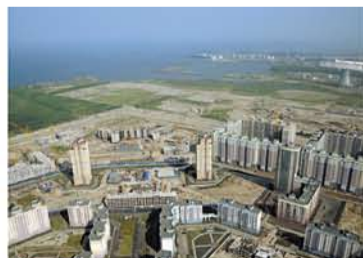
Инженерно-транспортное обеспечение Юго-Западной Приморской части Проектирование и строительство оакаймляющих магистралей 20 квартала ЮЗПЧ (Ленинский пр. от ул. Доблести до пр. Героев; пр. Героев от Ленинского пр. до ул. Маршала Захарова; ул. Маршала Захарова от ул. Доблести до пр. Героев; проезд между кварталами 20 и 20А).
