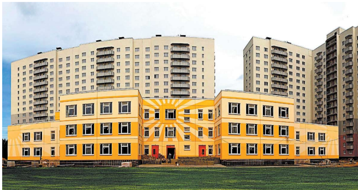
ДЕТСКОЕ ДОШКОЛЬНОЕ УЧРЕЖДЕНИЕ В ПОС. ОСИНОВАЯ РОЩА, САНКТ-ПЕТЕРБУРГ. ГЕНЕРАЛЬНЫЙ ПОДРЯДЧИК — ОАО «ПО «БАРРИКАДА» (ПРЕДПРИЯТИЕ «ГРУППЫ ЛСР»)
