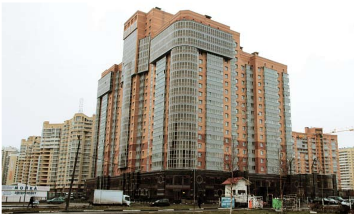
ЖИЛОЙ ДОМ НА ЛЕНИНСКОМ ПР., 78 ВОЗВЕДЕН КОМПАНИЕЙ «ГДСК»
