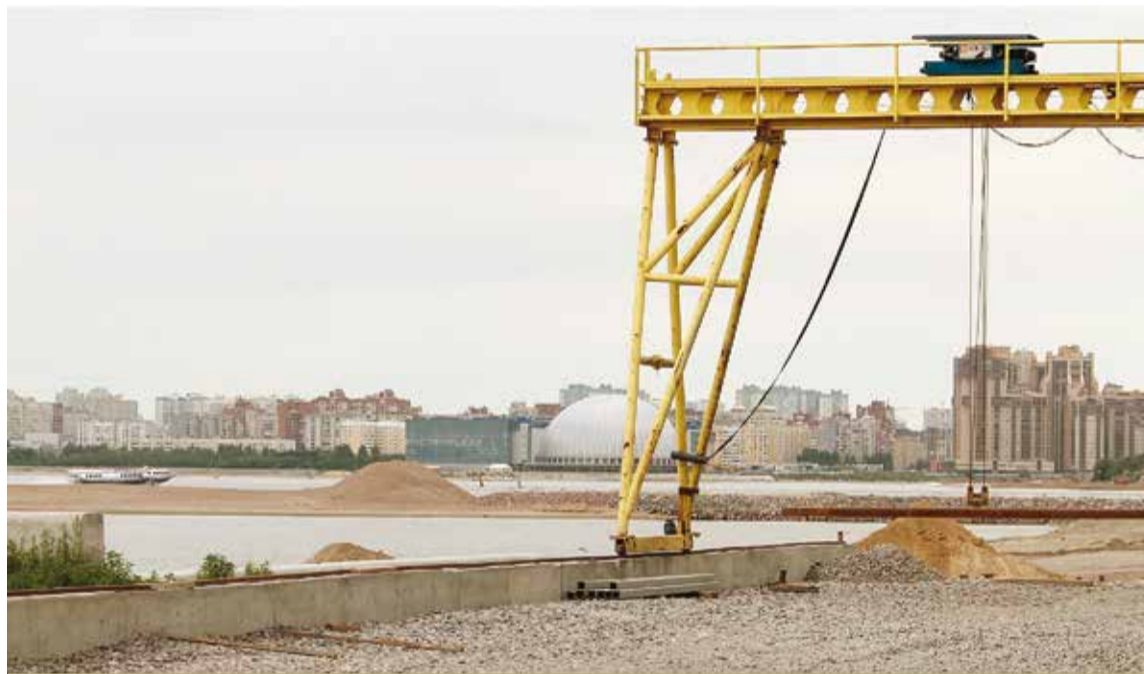
СТРОИТЕЛЬНАЯ ПЛОЩАДКА НА КРЕСТОВСКОМ ОСТРОВЕ БУДЕТ ГОТОВА В ИЮЛЕ
