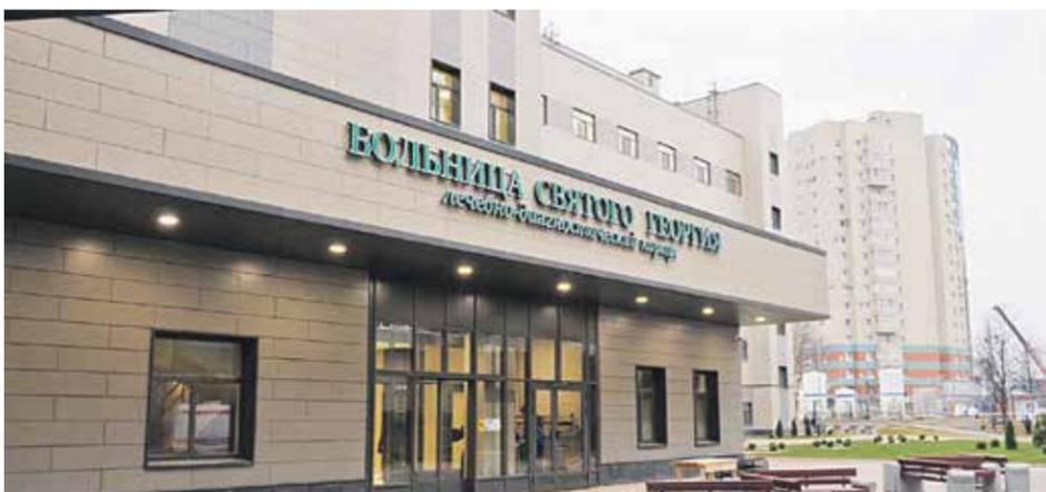
Так, стены нового корпуса представляют собой модульные конструкции, выполненные из так называемого металлического теплового профиля, заполненного утеплителем с гипсовыми строительными плитами внутри, отделочным слоем и керамическим вентилируемым фасадом снаружи.
