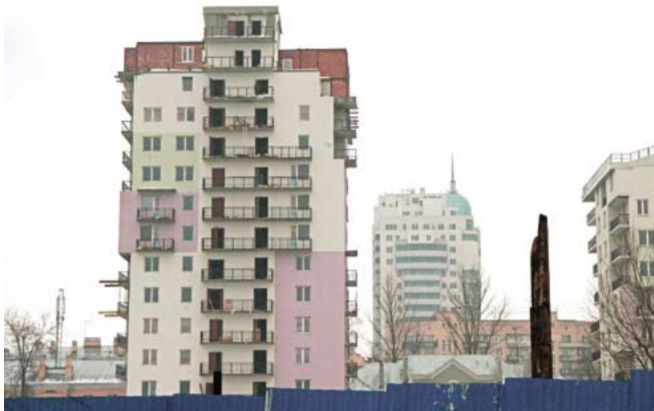
ЖИЛОЙ КОМПЛЕКС «ОХТА-МОДЕРН» БУДЕТ ЗАВЕРШЕН К КОНЦУ ЛЕТА ЭТОГО ГОДА. ОБЪЕКТ СТРОИТСЯ БОЛЕЕ 8 ЛЕТ
