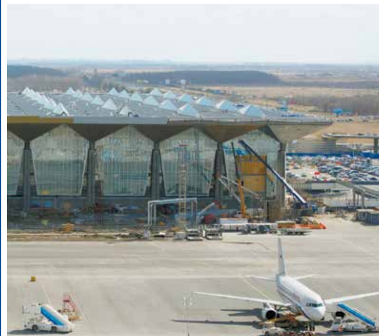
Аэропорт «Пулков» – поставка вентиляционного оборудования
