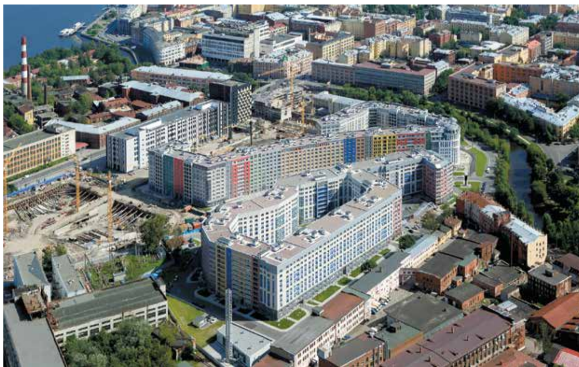
Строящийся ЖК «Самоцветы» на Васильевском острове
