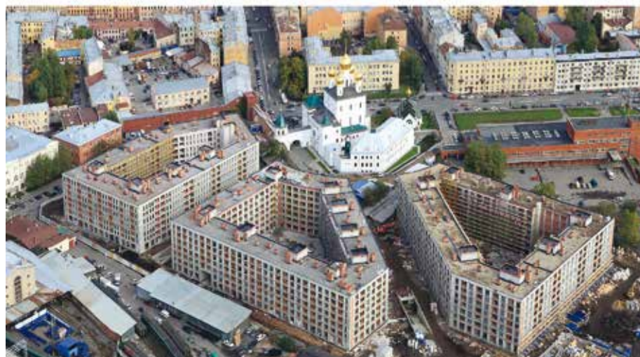
Строительство «Царской Столицы», сентябрь 2013 г.
