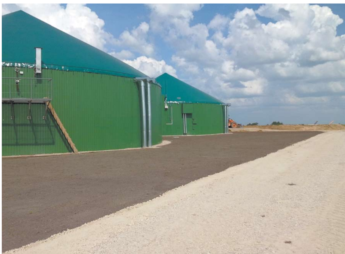
ОСНОВНОЙ И ДОПОЛНИТЕЛЬНЫЙ ФЕРМЕНТАТОРЫ СТАНЦИИ ЗЕМГАЛЕ
