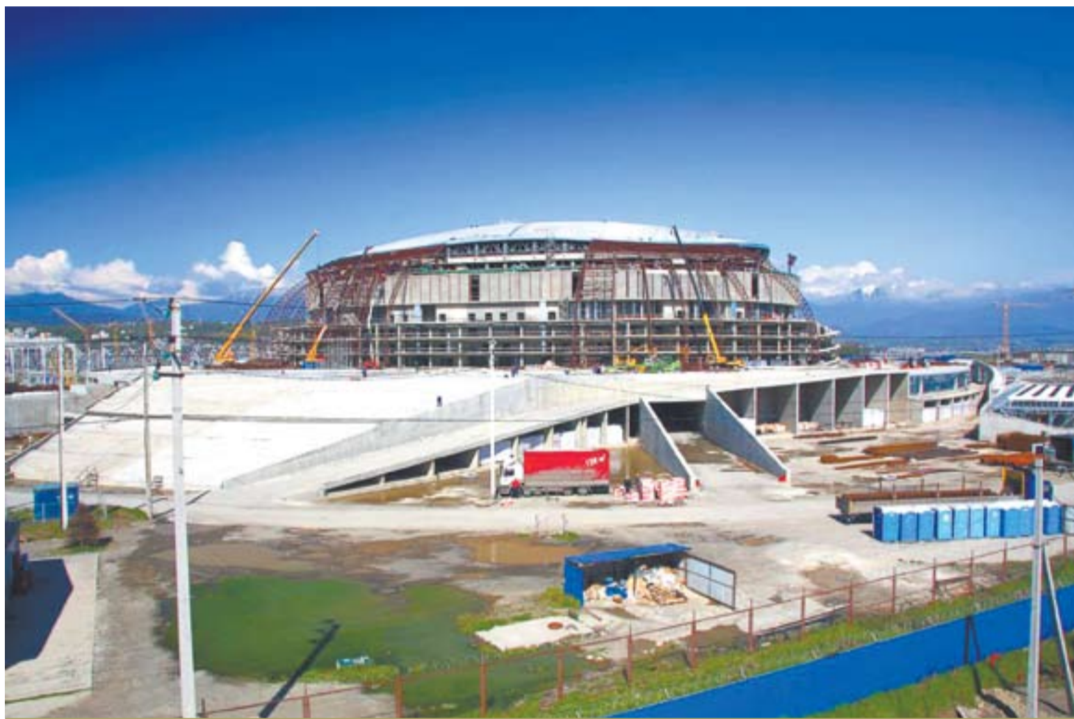
НА БОЛЬШОЙ ЛЕДОВОЙ АРЕНЕ МОНТИРУЮТ КУПОЛ
