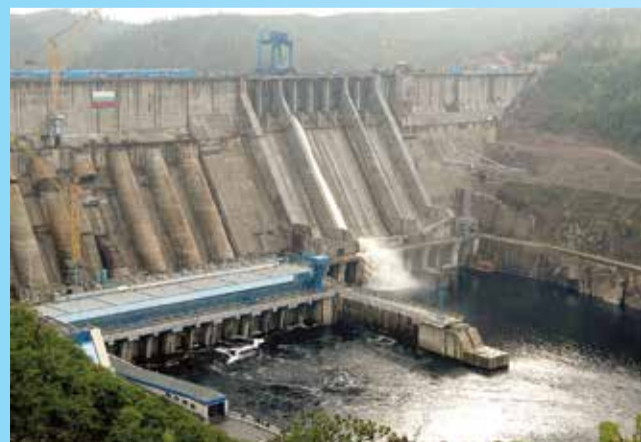
Работы по укреплению конструктивов отводящего канала плотины Бурейской ГЭС, устройство свайных стен из трубного шпунта d=720 и 1020 мм (п. Талакан, Амурская обл., Бурейский р-н).
