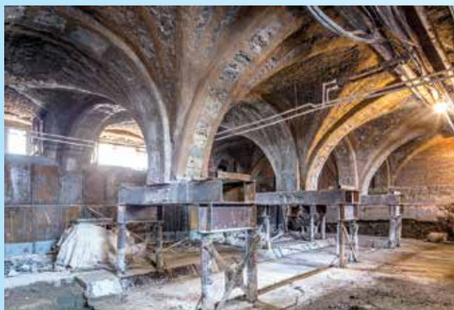
Александровский дворец (г. Пушкин, ГМЗ «Царское Село»). Реконструкция, приспособление для современного использования. Вывешивание исторических колонн с подведением новых фундаментов.
