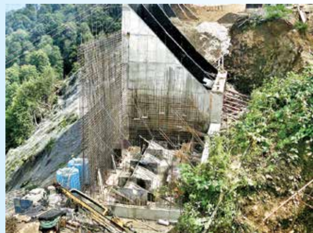
Инженерная защита олимпийских объектов в районе Красной Поляны (Сочи). Подпорная стенка станции канатных дорог горнолыжного курорта «Альпика Сервис» на отметке +780 м.
