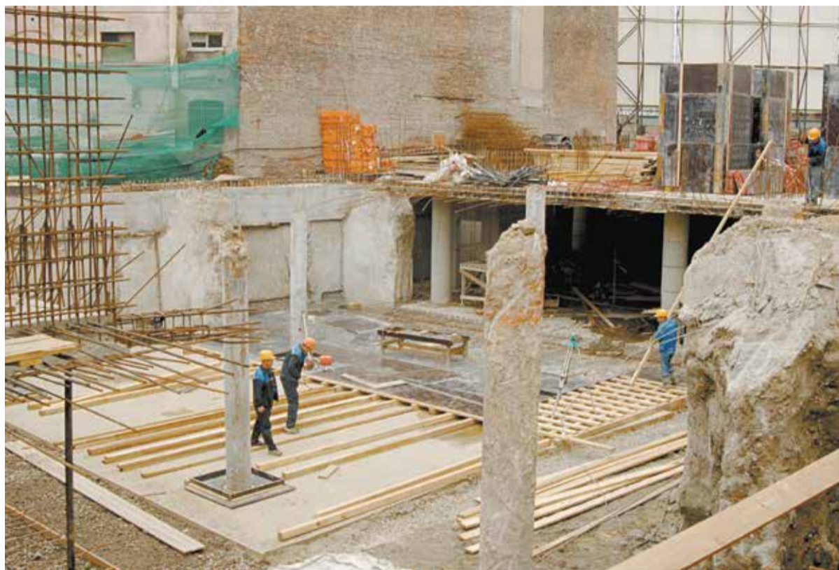
Строительство трехуровневого подземного паркинга в Зоологическом переулке
