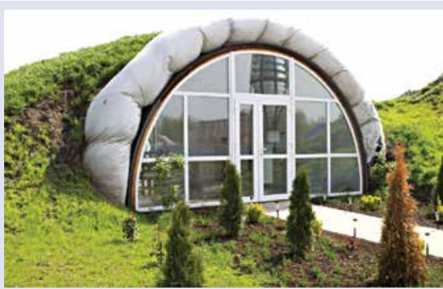
Дачный дом директора Центра деконатаматериалов Тюменского ГАСУ Виктора Рядинского. Площадь экспериментального экодому — 70 квадратных метров. К жилищу подведены коммуникации и электричество. Хозяин дома отмечает, что даже в зимнее время для отопления помещения достаточно подогреваемого пола. Главная особенность сооружения — это строительный материал, который получен из переработанных материалов
