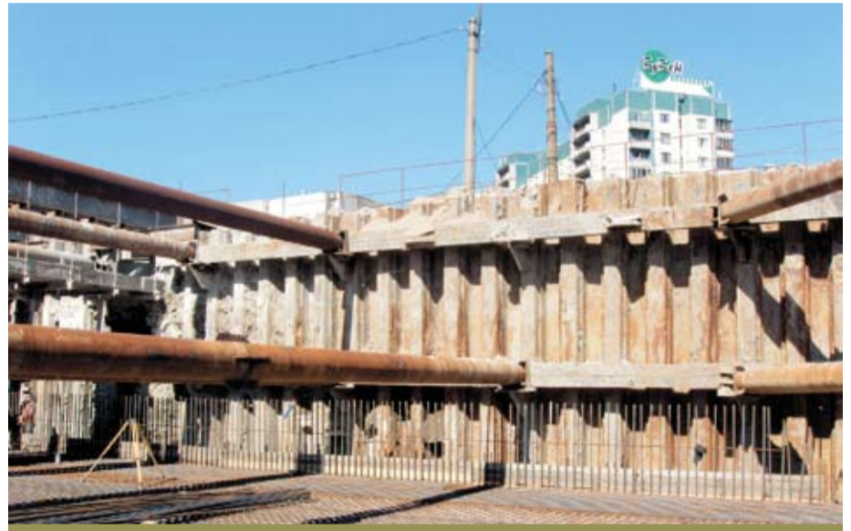
ОБЪЕКТ ЗАО «ГЕОСТРОЙ»: ОГРАЖДЕНИЕ КОТЛОВАНА ПРИ СТРОИТЕЛЬСТВЕ ПОДЗЕМНОГО ПЕШЕХОДНОГО ПЕРЕХОДА НА КОМЕНДАНТСКОМ ПРОСПЕКТЕ
