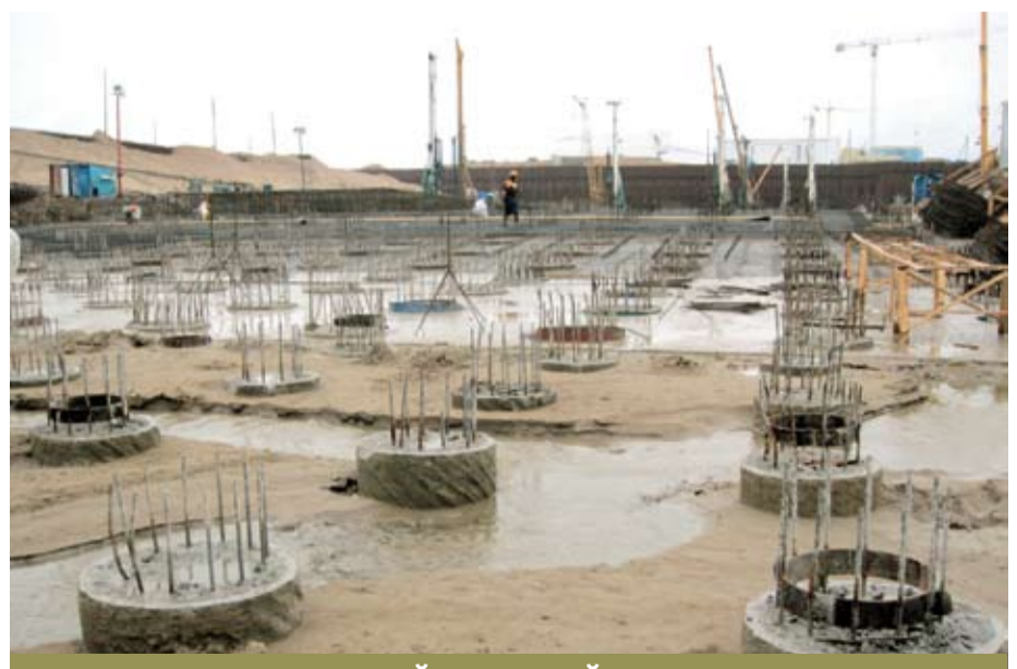
ОБЪЕКТ ЗАО «ГЕОСТРОЙ»: УСТРОЙСТВО БУРОНАБИВНЫХ СВАЙ ПРИ СТРОИТЕЛЬСТВЕ КОМПЛЕКСА ЗАЩИТНЫХ СООРУЖЕНИЙ
