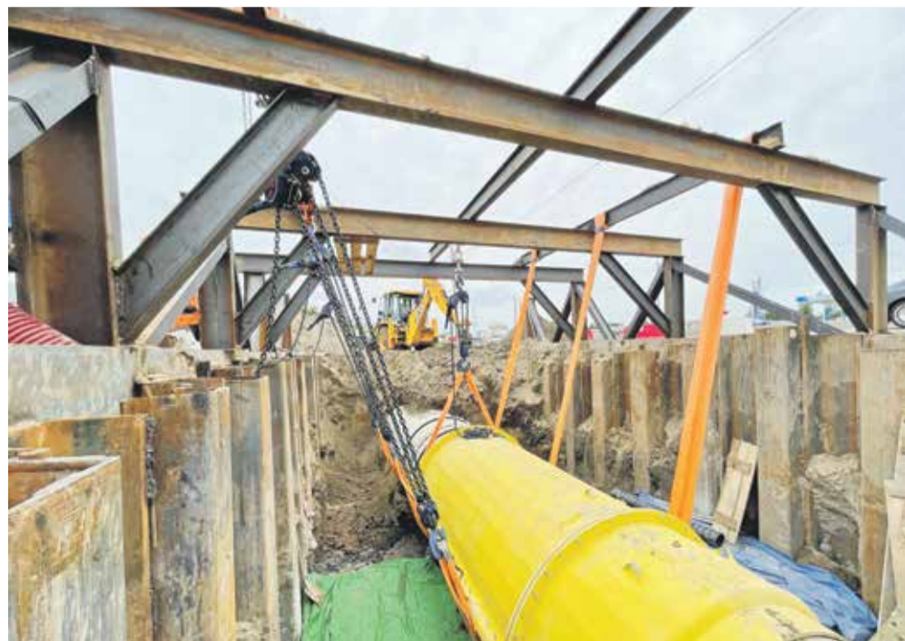
Специалисты «МегаМейд» осуществляют монтаж сборно-разборного защитного футляра на действующем стеклопластиковом трубопроводе. Июль 2022 года
