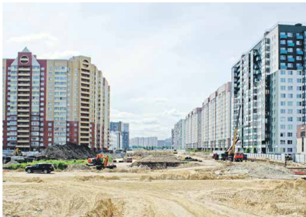
Строительство инженерно-транспортной инфраструктуры в квартале СУН-16 (Невский район Санкт-Петербурга)
