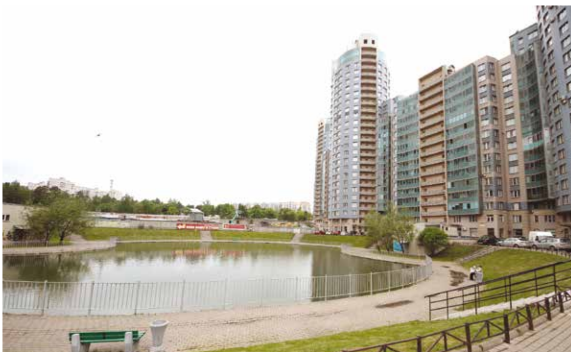
ПО ГЕНПЛАНУ САНКТ-ПЕТЕРБУРГА НА УЧАСТКЕ ВОЗМОЖНО СТРОИТЕЛЬСТВО ОБЪЕКТА СПОРТА И ЖИЛЬЕ
