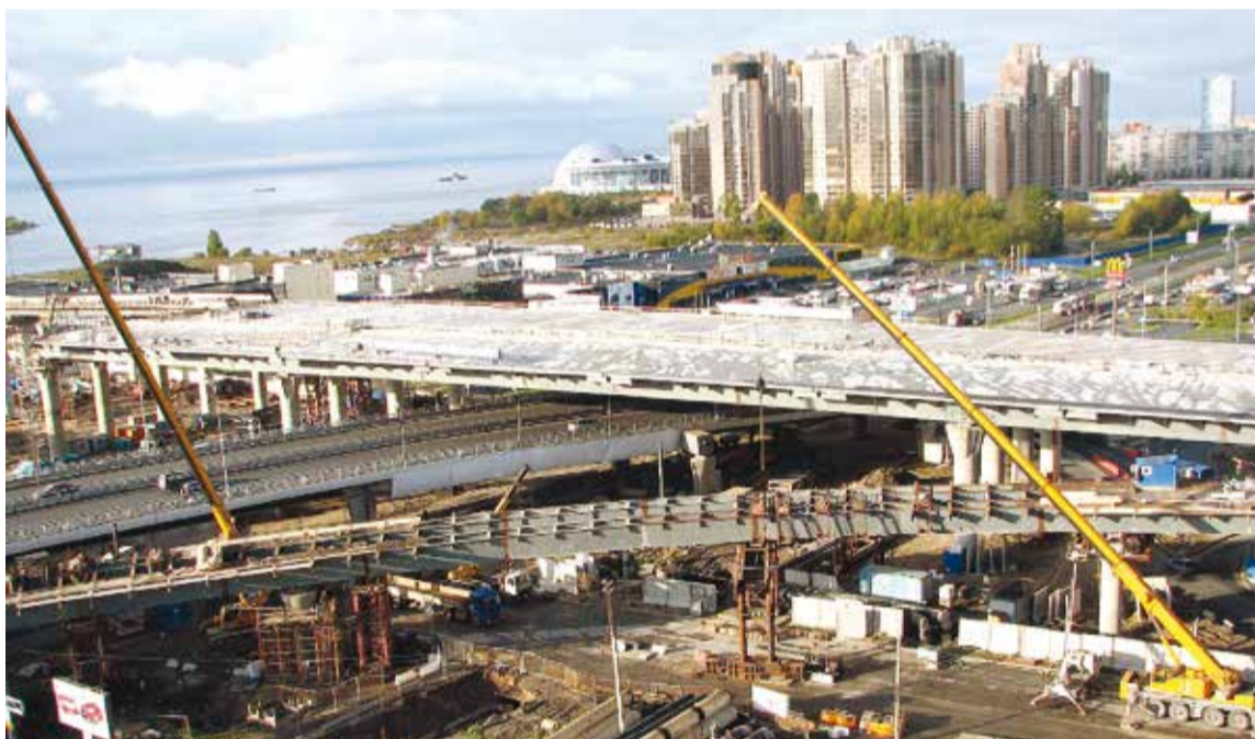
ЦЕНТРАЛЬНЫЙ УЧАСТОК ЗСД ПРАКТИЧЕСКИ ПОЛНОСТЬЮ ПРОЙДЕТ НАД ВОДОЙ
