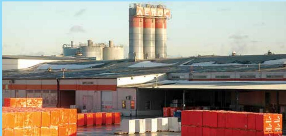
**«Аэрок СПб»** – крупнейшее предприятие по производству ячеистого бетона в Северо-Западном регионе, выпускающее газобетонные блоки автоклавного твердения.
